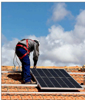
Instalación de un panel solar. ALBERTO DI LOLLU
