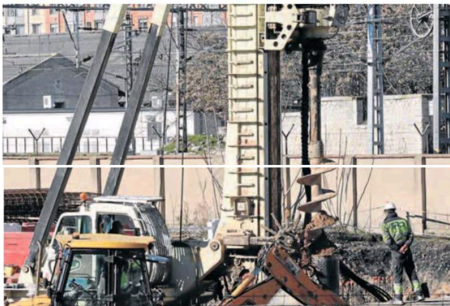
Obras entre el túnel de Labradores y la calle Panaderos para el nuevo paso subterráneo licitada por varias administraciones. CARLOS ESPESO
