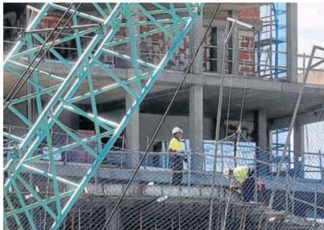
Dos obreros trabajan en un bloque de viviendas en el barrio de Villa de Prado. CARLOS ESPESO
