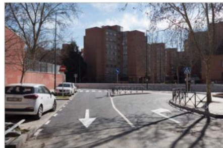
Tráfico abierto en ambos sentidos en el entorno del túnel.
