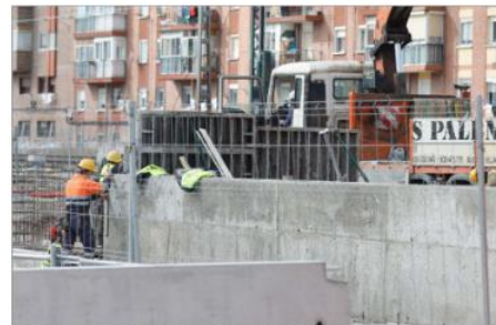
Trabajos para finalizar las obras de Andrómeda.
