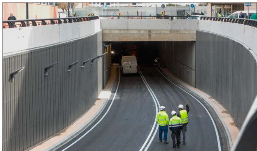
Tres operarios recorren ayer el túnel de Andromeda, que continúa sin fecha prevista para su apertura al tráfico. EM
