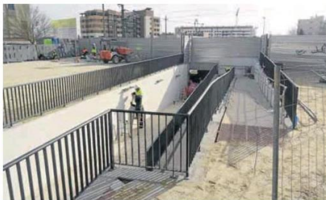
Remates en la boca del paso peatonal que discurre en paralelo al de vehículos. c. ESPESO
