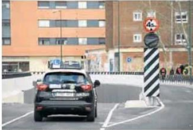
Entrada al túnel desde la calle Nochevieja. RODRIGO JIMÉNEZ
