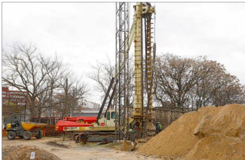
Máquina para la realización de los agujeros sobre los que irán los pilotes. J.M. LOSTAU
