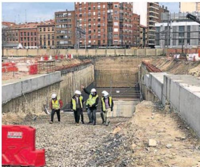
Oscar Puente y los responsables de la obra salen de la zona ferroviaria en la que se está trabajando. A. v.
