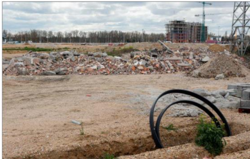
Terrenos de Arroyo en los que Mercadona construirá un nuevo supermercado. J.M. LOSTAU
