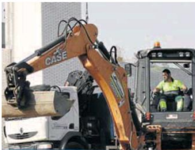
Un hombre trabaja con una máquina excavadora en una obra. EP
