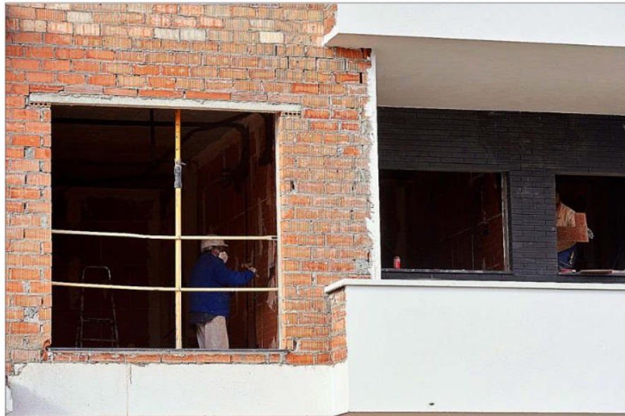
Trabajadores de la construcción realizan tareas en un edificio en obras en el municipio granadino de Armilla. GOGO LOBATO
