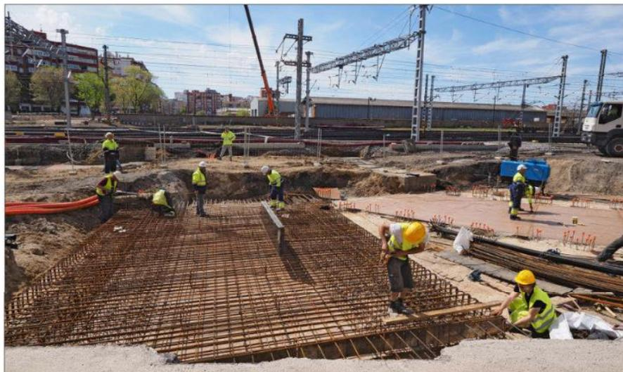
Construcción de la losa para que el tráfico circule por la calle Estación. PHOTOGENIC
