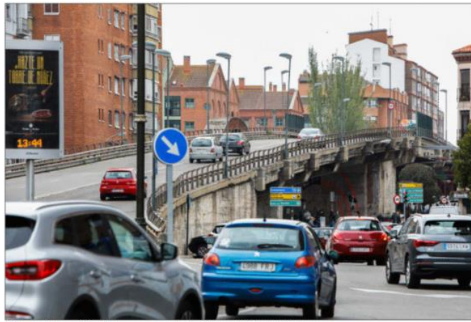
Viaducto del Arco de Ladrillo en su acceso desde el Paseo del Hospital Militar. J.M. LOSTAU
