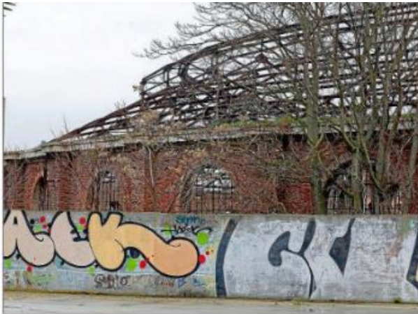
Imagen de parte de la estructura del depósito de locomotoras. E. M.
