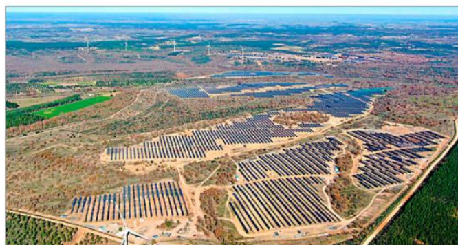
Estación fotovoltaica de Santiz, en el término municipal salmantino de Valdeosa. SOLARIA
