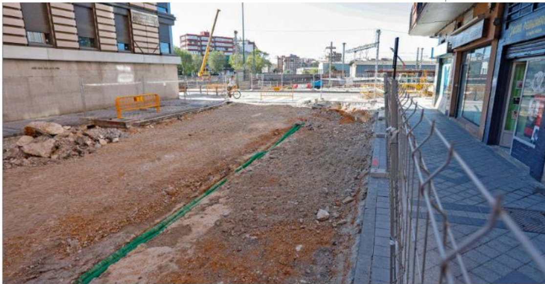
Obras para construir el túnel en la calle Panaderos en la conexión con las vías del tren. J.M. LOSTAU
