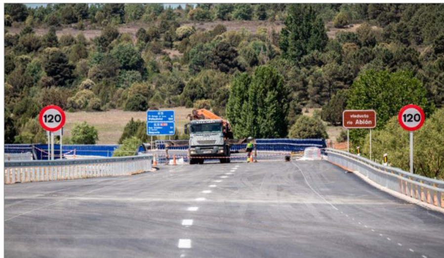
Un equipo de operarios trabajando en los últimos remates del tramo Venta Nueva-Santiuste el pasado viernes. GONZALO MONTESEGURO
