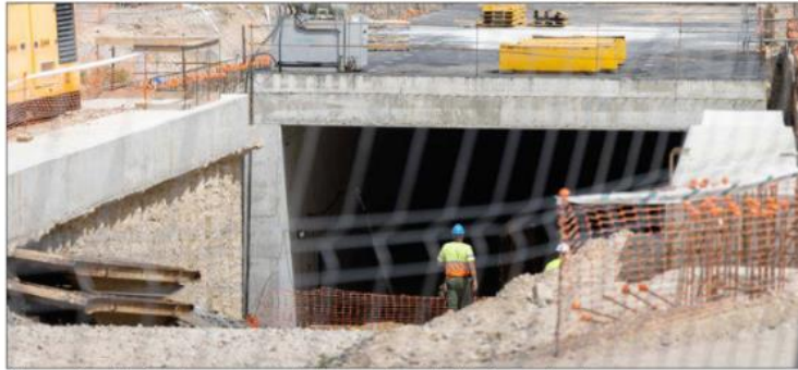
Obras en el túnel de Panaderos, ayer, con el cajón para el paso de vehículos ya colocado. PHOTOGENIC
