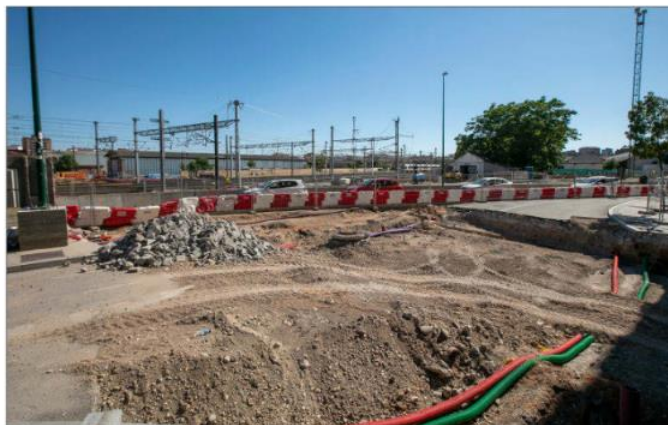
Estado de las obras, ayer, en la zona donde se colocará el cajón de Panaderos. PHOTOGENIC
