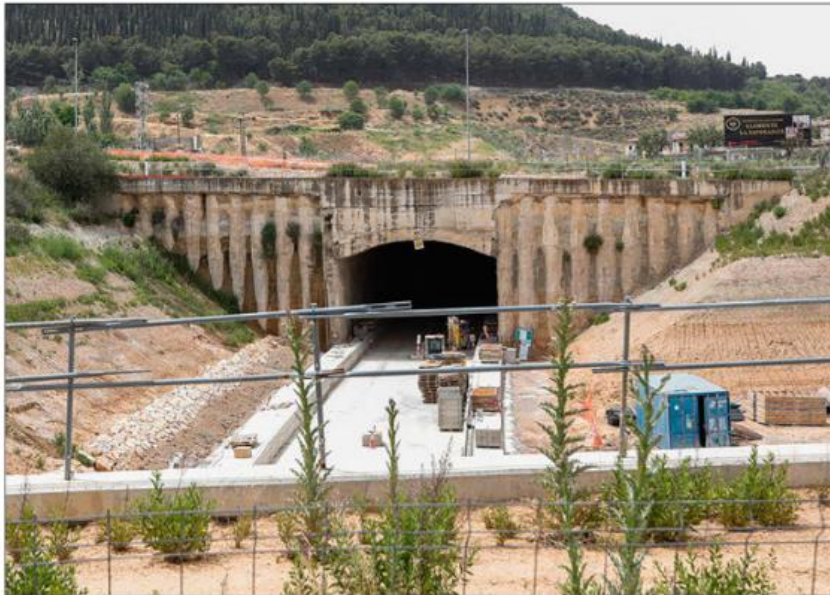
Obras de la Variante Este de mercancías de Valladolid. J.M. LOSTAU
