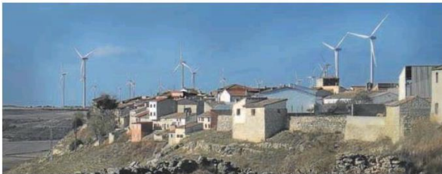
Vista de Peñaflor de Hornija, rodeado por algunos de los aerogeneradores instalados en su término municipal. RAMÓN GÓMEZ
