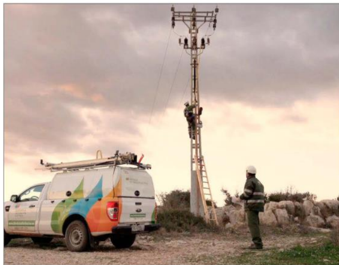
Dos operarios de i-DE realizan labores de mantenimiento en una torre eléctrica. E. M.
