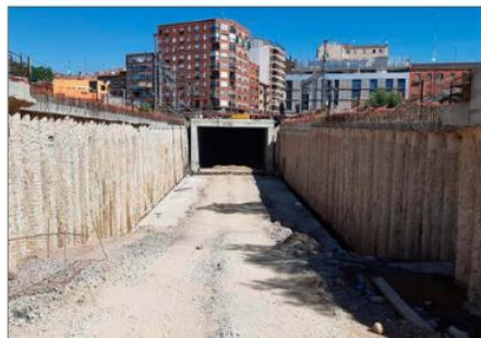
Obras del túnel de la calle Panaderos. E.M.
