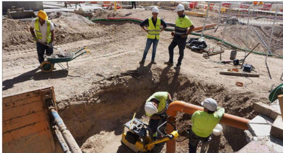
Operarios, ayer, en las obras del túnel de Panaderos en la esquina de la calle Estación. PHOTOGENIC
