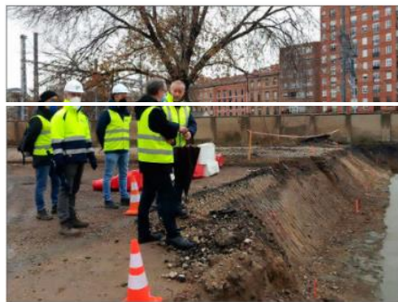
Saravia en una visita en el comienzo de las obras en Panaderos. E.M.
