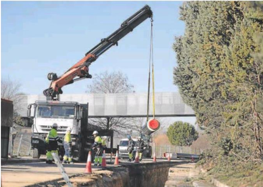
Colocación de un tubo de la red de calor, en la calle Padre José Acosta, a la altura de Villa de Prado. JOSÉ C. CASTILLO
