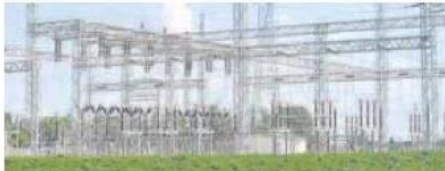
ENERGÍA. La subestación eléctrica de La Mudarra, que distribuye tanta electricidad como una central nuclear, es vital no solo para Valladolid sino para la mitad norte de España. RODRIGO JIMÉNEZ
