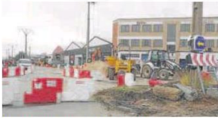
Obras en Forja con Avenida de El Norte de Castilla. J. SANZ
