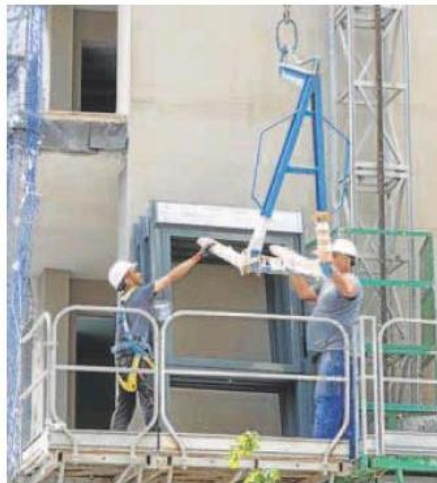
Dos empleados, en una obra en Valladolid. R. FRAILE
