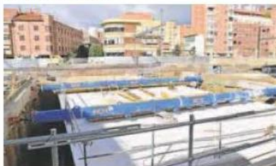
Obras del paso de Padre Claret. R. JIMÉNEZ
