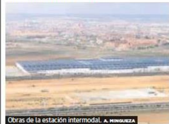
Obras de la estación intermodal. A. MINGUEZA
