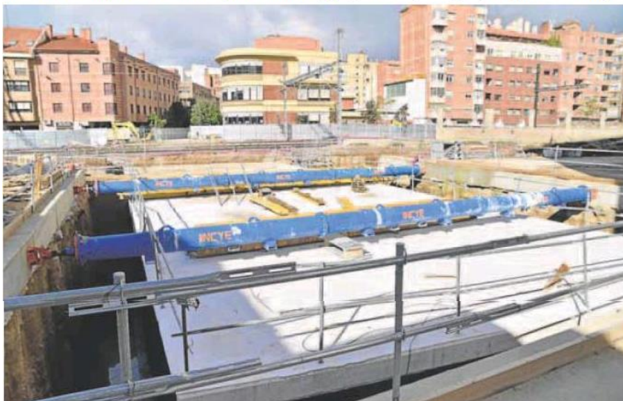
Obras de cimentación del cajón que se instalará bajo la vía en los accesos desde Padre Claret hacia la Circular. RODRIGO JIMÉNEZ
