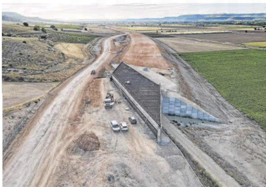
Uno de los tramos en obras de la A-11. EL NORTE
