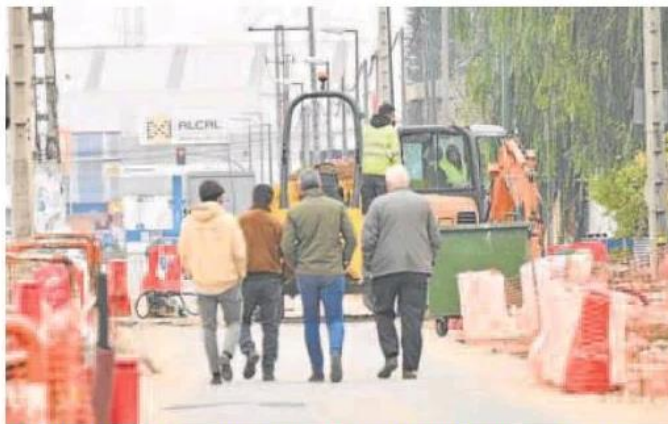
Obras de reurbanización de la avenida de El Norte de Castilla en el polígono de Argales. RODRIGO JIMÉNEZ
