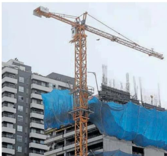
Un edificio de viviendas en construcción. EFE
