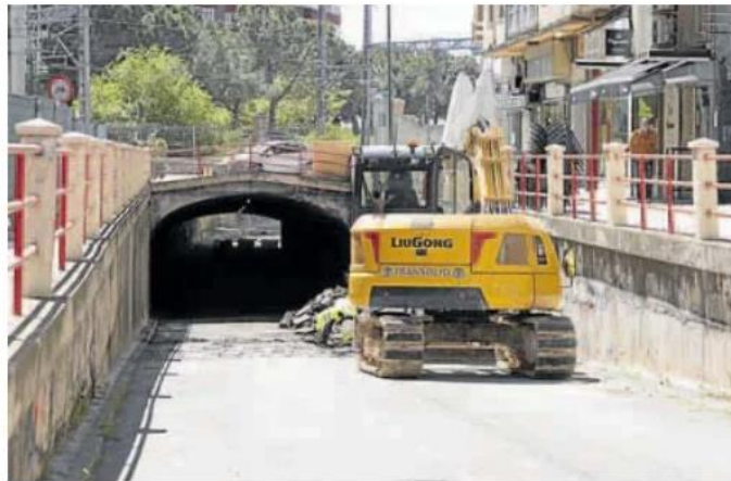
Una máquina, en los recién reinaugurados trabajos en el paso de Labradores. A. MINGUEZA
