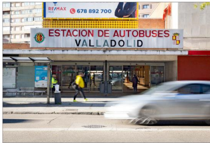
Recreación exterior de la estación de autobuses de Valladolid tras las obras de remodelación. JCYL
