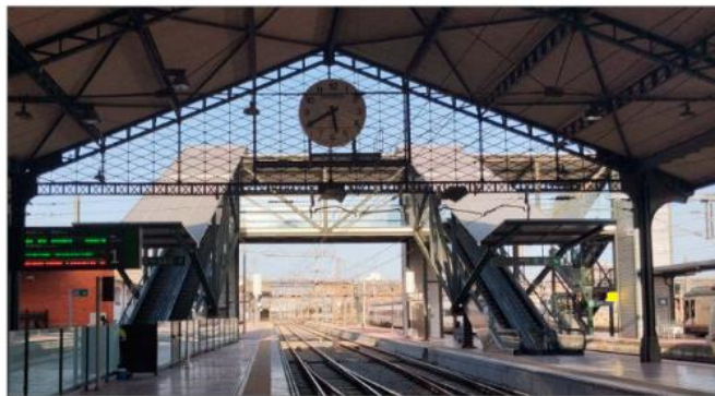
Estación de tren Valladolid-Campo Grande. E.M.
