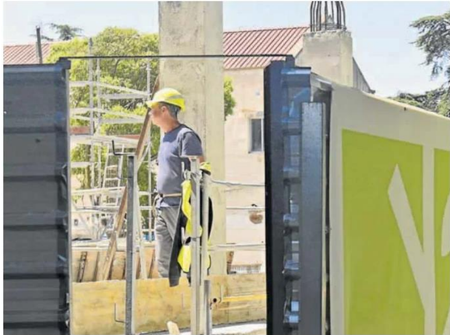
Un trabajador de la construcción en una obra en el Paseo de Zorrilla el pasado junio. RODRIGO JIMÉNEZ
